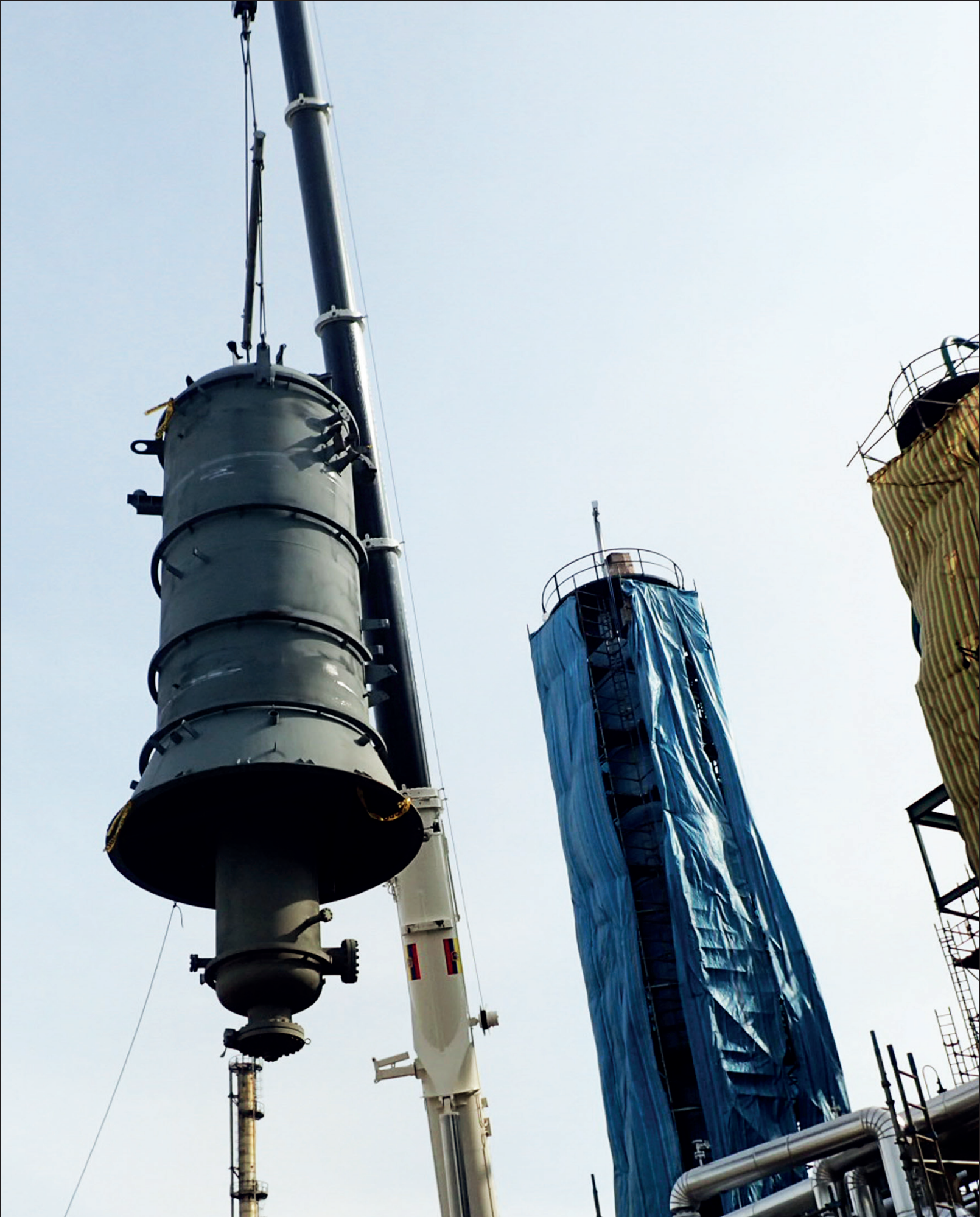
Instalación de Nuevo Equipo Striper Residum TV1-V3. Rehabilitación Intregal No Catalíticas 2, Refinería de Esmeraldas.
