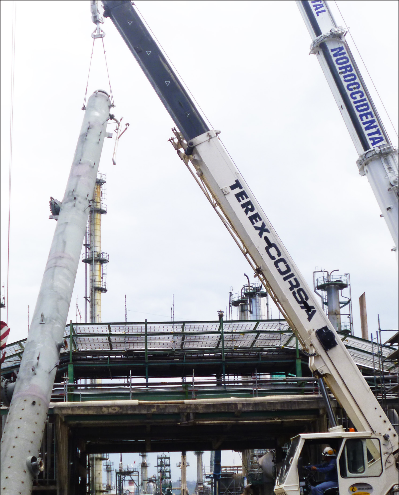
Instalación de Nuevo Equipo VL-V6. Rehabilitación de Unidad No Catalíticas 1, Refinería de Esmeraldas.
