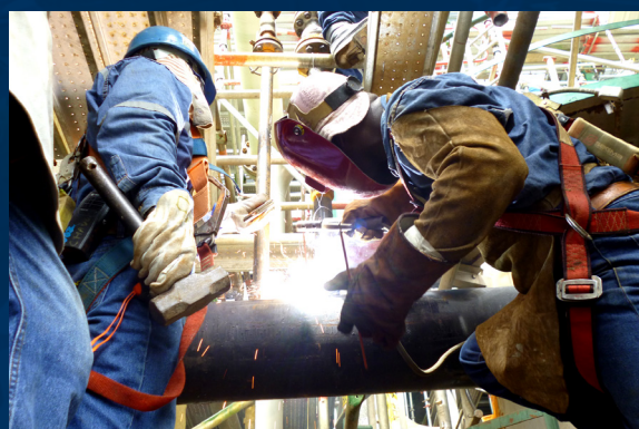
Trabajos de soldadura en línea de 10" Acero al Carbón en Trampa Rascadores en REE
