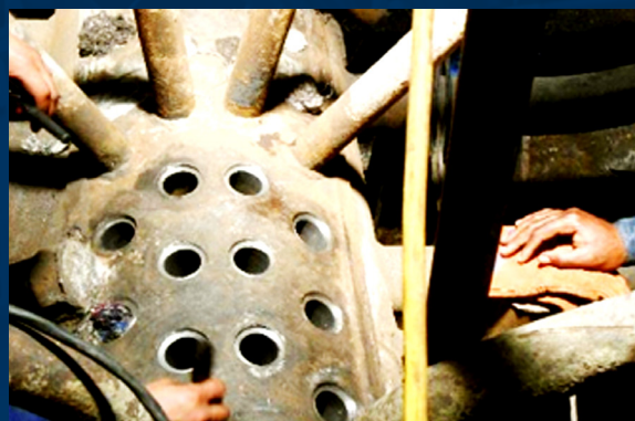
Cambios de serpentines de alta temperatura de la caldera de CELEC – Termoesmeraldas 1
