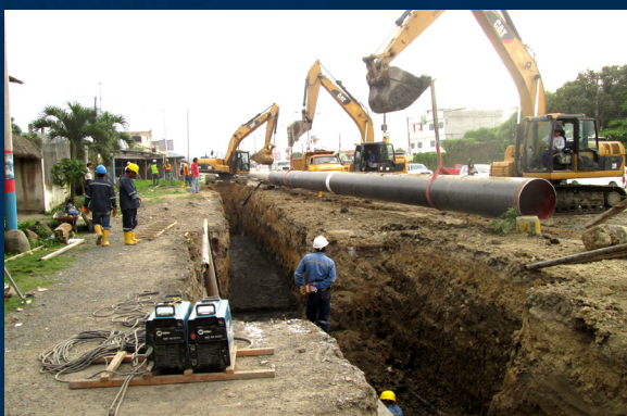
Instalación de tubería para acueducto de 900mm tramos de 3.2 km, ciudad de Esmeraldas
