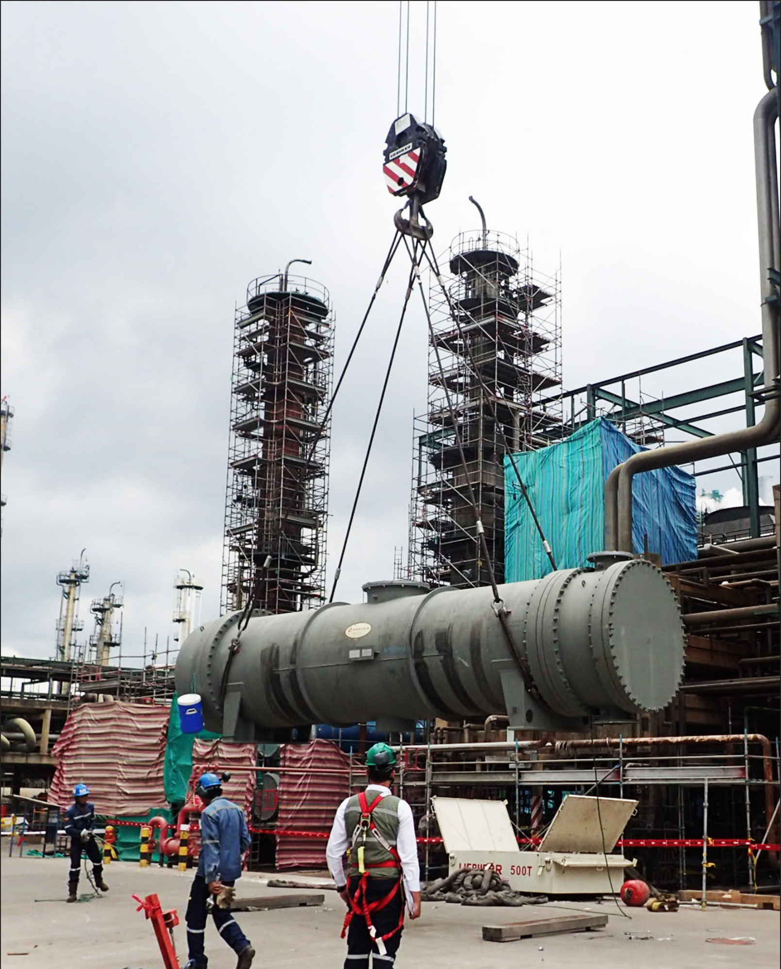
Montaje de Nuevos Intercambiadores de Calor. Rehabilitación Integral de Unidad No Catalíticas 2, Refinería de Esmeraldas.
