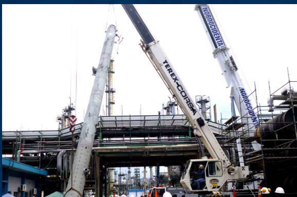
Montaje de Torre TV-V6 en REE
