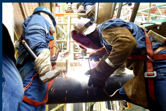
Trabajos de montaje mecánico en la nueva captación del sistema regional de agua potable
