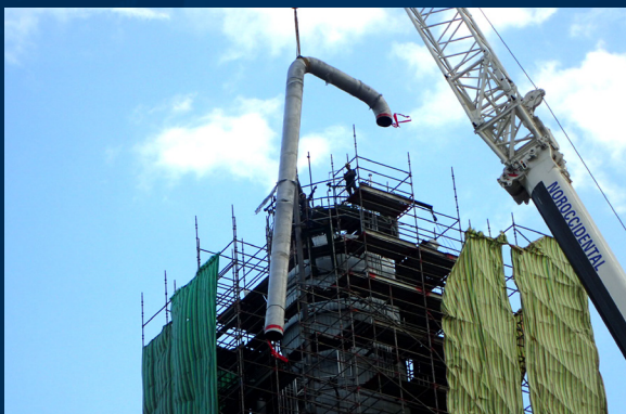
Instalación de línea de 24" en torre de Destilación Atmosférica CV13 de REE
