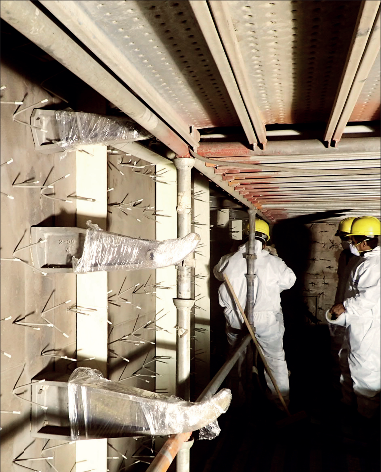
Mantenimiento Integral Horno VL-H1. Cambio de Refractores en Zona de Radiación. Rehabilitación Integral de Unidad No Catalíticas 2, Refinería de Esmeraldas.
