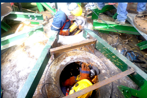
Provisión e reemplazo de boquillas en Torres CV-1 y CV-13 en REE
