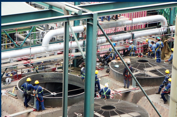
Mantenimiento de Aeroenfriadores en Refinería de Esmeraldas
