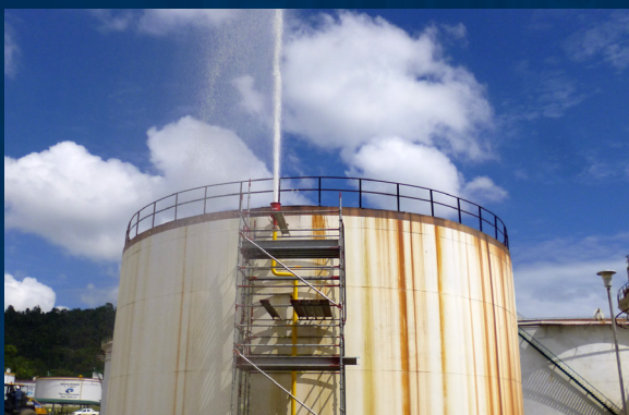
Cambios de tuberías y cámaras de espuma del sistema de contraincendio de tanques
