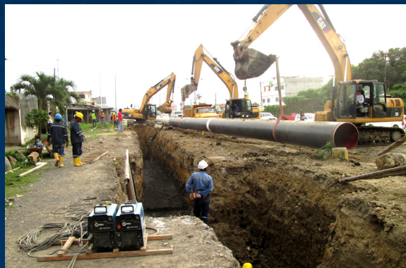
Montaje de líneas en cruce de vía en REE
